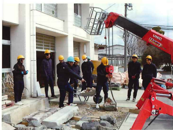
フロークレーンでチェーンスリングを使用した石材の玉掛け実習
